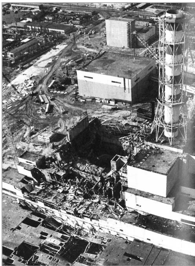
Разрушенный энергоблок Чернобыльской АЭС. Сюда одним из первых проник на танке начальник энергетического отдела КГБ СССР В.А. Поделякин.
