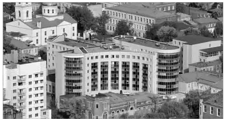
Нынешнее здание УФСБ было сдано в эксплуатацию 22 января 2010 года. Проект ОАО «Волгоэнергострой-проект».
